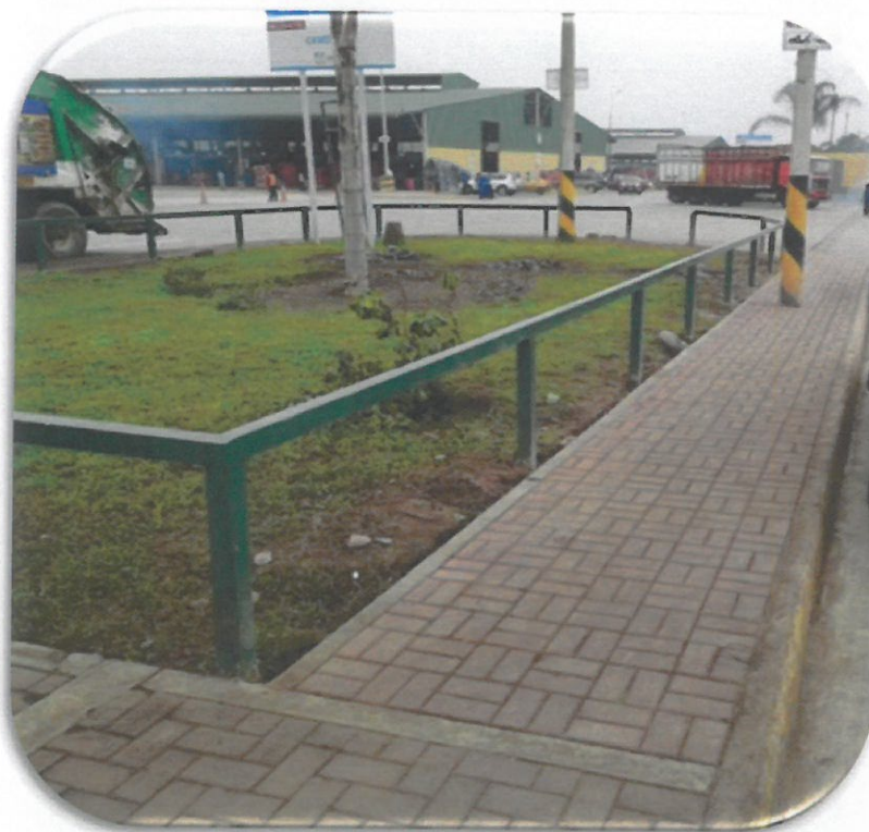
Adoquinado de veredas en isla vía principal
