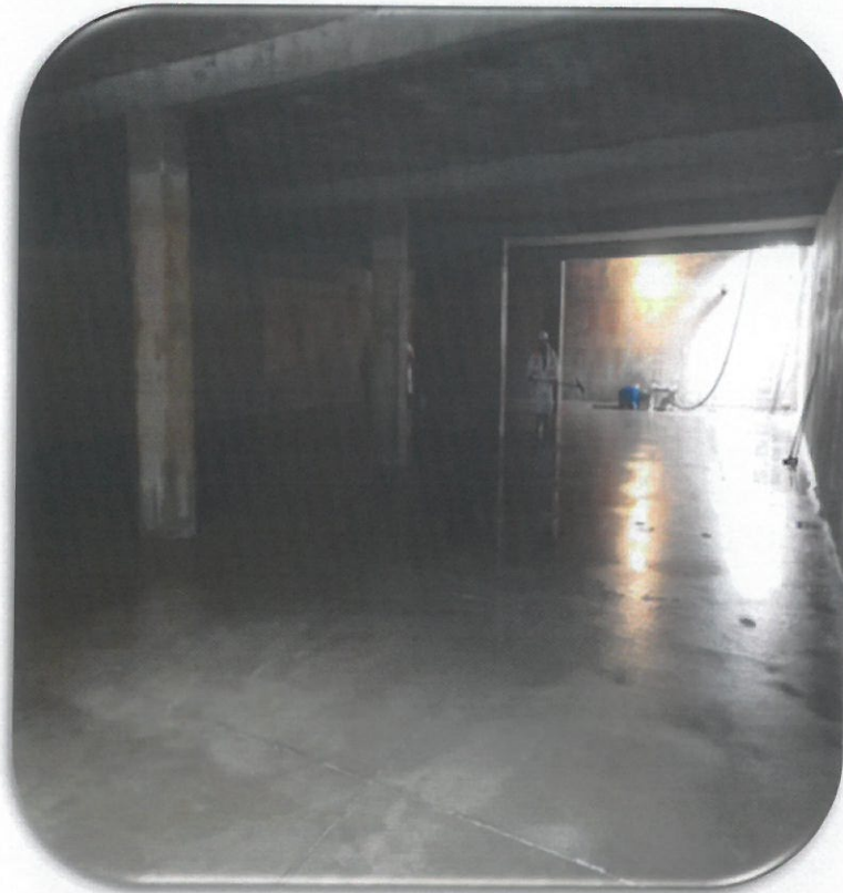
Impermeabilización cisterna de 650 m3
