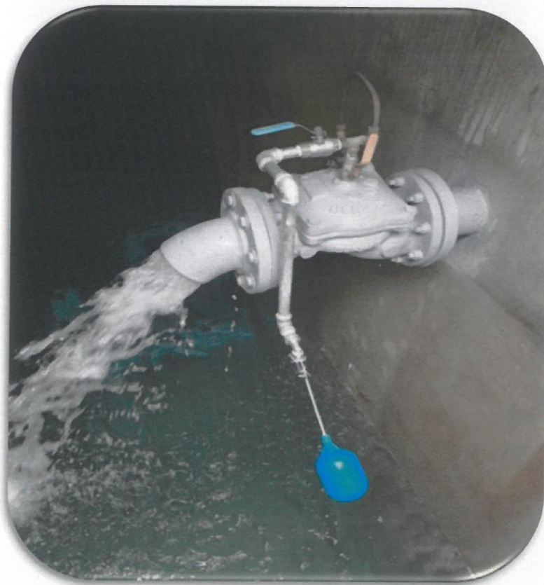
Reparación válvula control de ingreso de agua
