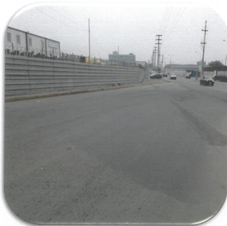
Reposición de pista de asfalto en Puerta N° 1
