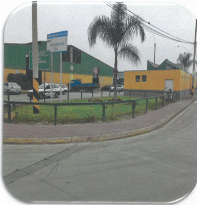
Adoquinado de veredas islas adyacente a Sub Estación
